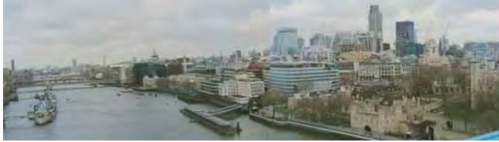
صورة ( ٣٨ ) منظر لضفاف التيمز من فوق كويري البرج المصدر : نهى جمال , ٢٠٠٢
