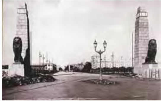
صورة (٤٩) كوبري قصر النيل الجديد الذي أطلق عليه الملك فواد اسم والده الخديوي إسماعيل و الذي أعيد بناؤه عام ١٩٣٣ المصدر : مجلة مدينة - العدد رقم ١٦ - ٢٠٠٠
