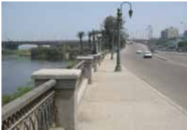
صورة (٥٦) منزل كوبري روض الفرع المصدر : الباحث , ٢٠٠٥
