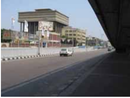
صورة (٧٧) خزان مياه امبابه المصدر : الباحث , ٢٠٠٥
