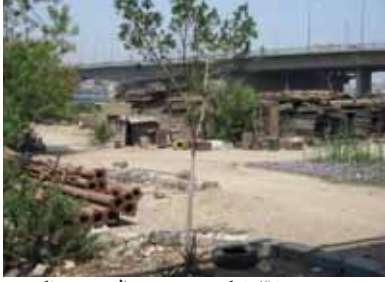
صورة (٥٣) كوبري روض الفرع بعد فكّه و وضعه علي الضفة النيل الشرقية المصدر : الباحث , ٢٠٠٥
