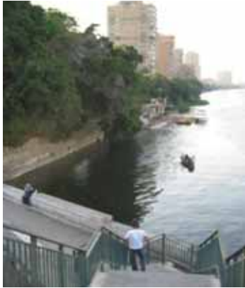
صورة (٧٠) لقطة توضح منزل المشاة لكوبري ١٥ مايو و يتضح في الصورة اتصال قطع الأراضي علي الضفة الشرقية للنهر المصدر : الباحث , ٢٠٠٥
