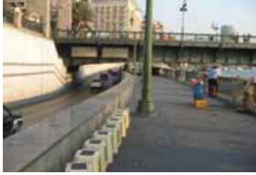
صورة (١٠٢) تقاطع طريق الكورنيش مع كوبري قصر النيل المصدر : الباحث, ٢٠٠٥
