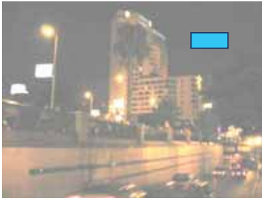
صورة (١١٤) فندق سيمراميس المصدر : الباحث, ٢٠٠٥
