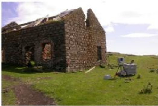
شكل(6): يوضح كيفية توثيق المبنى بواسطة تقنية 3D Laser Scanning المصدر- الباز، منير (2006)
