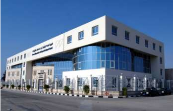
شكل ( 10 - 1 ) الواجهات الخارجية لمبنى الهيئة
