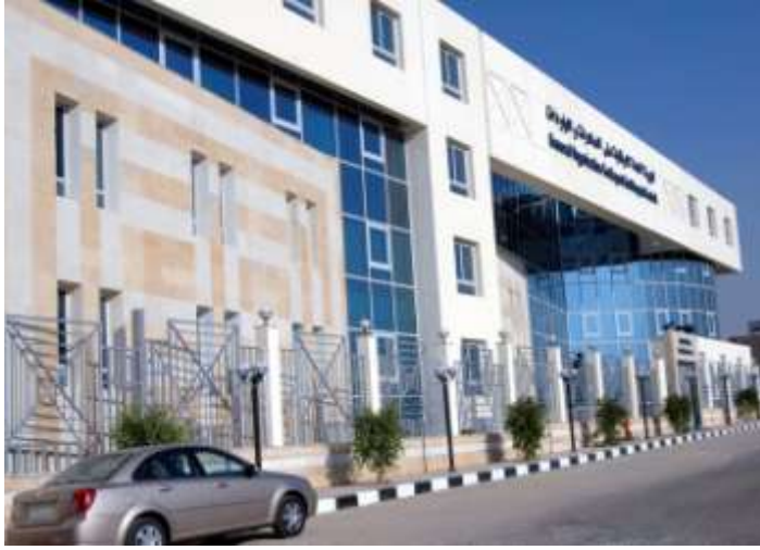
شكل ( 10- 2 ) الواجهة الرئيسية لمبنى الهيئة المصدر ( مكتب ضياء كونسلت )
