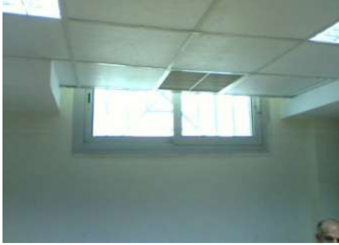
شكل (10- 12) بعض غرف الموظفين في البدروم تضاء بواسطة شبابيك علوية ضيقة المصدر ( الباحث )
