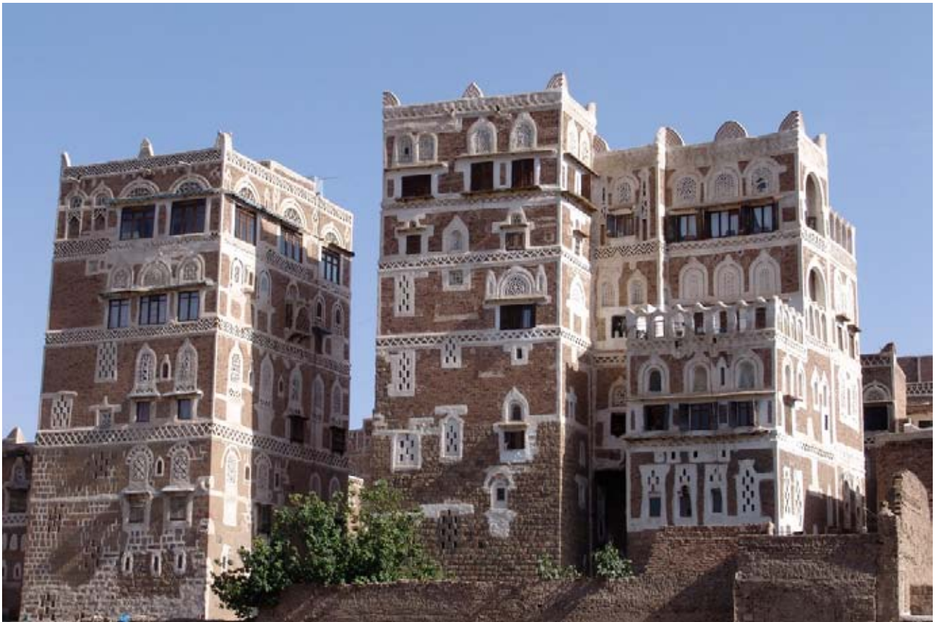
البيوت اليمنية القديمة لها دور وظيفي ... الدور الأرضي للمخازن ويعلوه حجرات النوم، والمطبخ يوجد في الدور الثاني أما جناح الضيوف «المفرج» فيوجد في الدور الأخير ويزدان بالقمريات المطعمة بالزجاج الملون .. بيوت يتفاعل فيها المعماري مع البيئة والتقاليد
